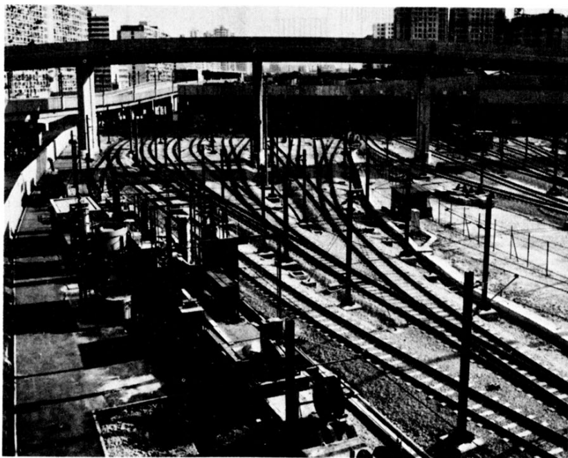
Fig. 9. Kowloon Bay Depot: north fan
